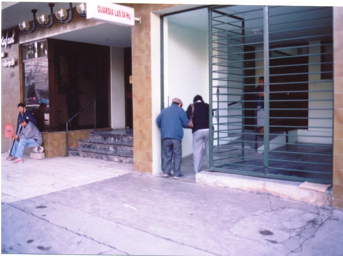
Fotografía N° 2 - Acceso al Centro de Diálisis INSAL S.R.L., de Clínica San Rafael – Rampa de acceso de longitud inadecuada.
