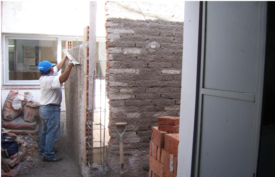
Punto 3. Obra en ejecución en el sector de hemodiálisis. Ampliación sala de lavado de filtros.
