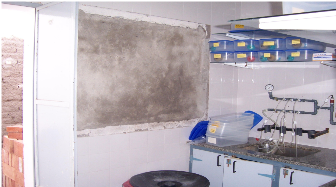
Punto 3. Obra en ejecución en sector de hemodiálisis. Sala de lavado de filtros
