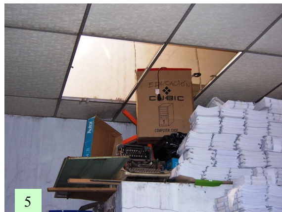
Archivo. Papelería voluminosa próxima al cielorraso
