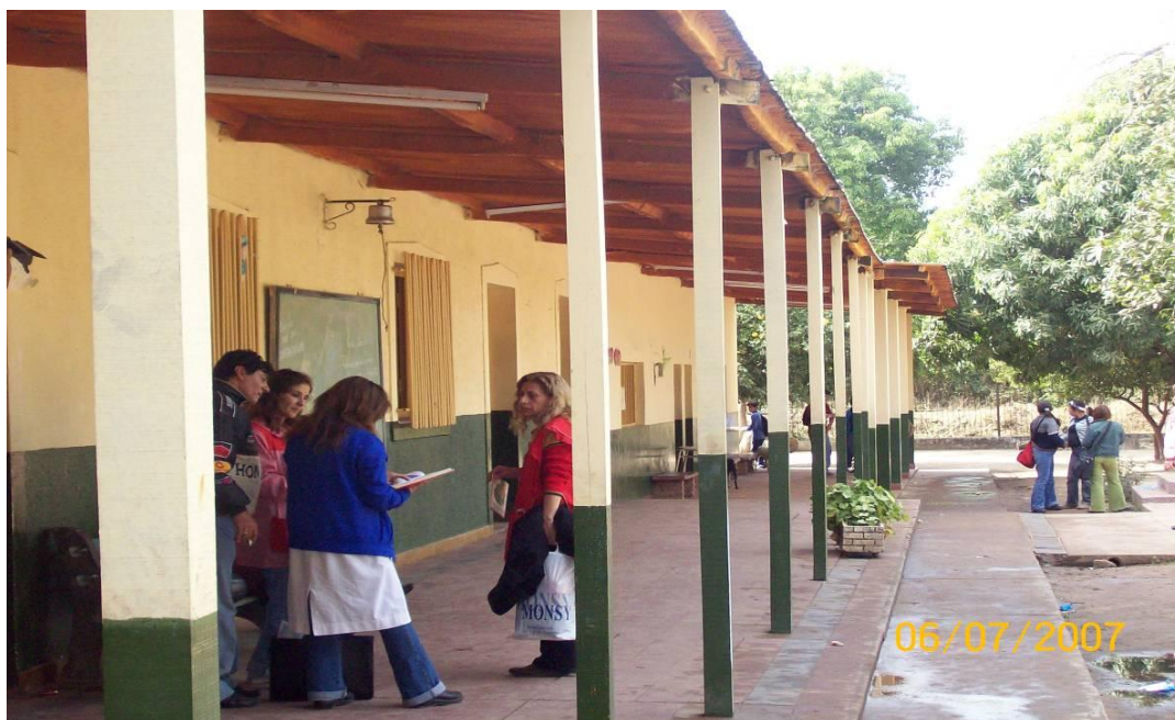
Fotografía N° 7: "Recambio de columnas de madera en galería" Ítem 3.02 del análisis de cómputo y presupuesto.
