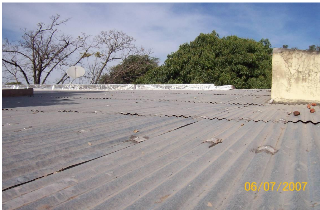
Foto N° 4 Ítem 3.01 “Aislación térmica con membrana de aluminio 4mm en cubierta” – Tareas Ejecutadas 45 mts.2 – Previstas: 450 mts.2
