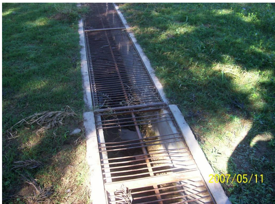
Fotografía N° 2. Rubro 5 – Canales de desagües pluviales.
