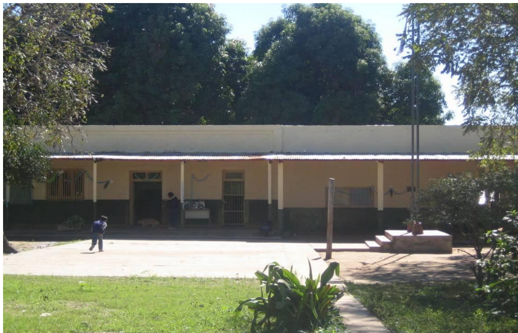
Foto N° 3 Ítem 3.01 “Aislación térmica con membrana de aluminio 4mm en cubierta” – Tareas Ejecutadas 45 mts.2 – Previstas: 450 mts.2
