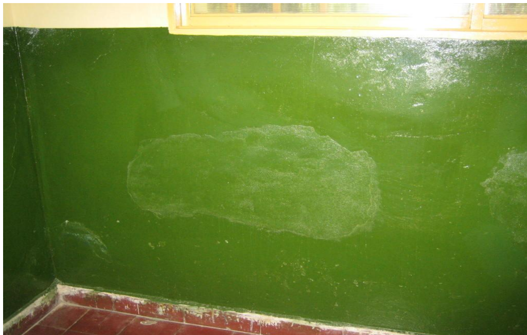
Fotografía N° 1. Ítem 2.01 "Revoques en General". Tareas Ejecutadas: 0.5 mts2 – Previstas 20 mts2
