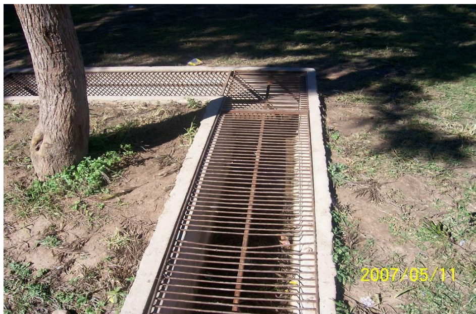
Fotografía N° 1. Rubro 5 – Canales de desagües pluviales.
