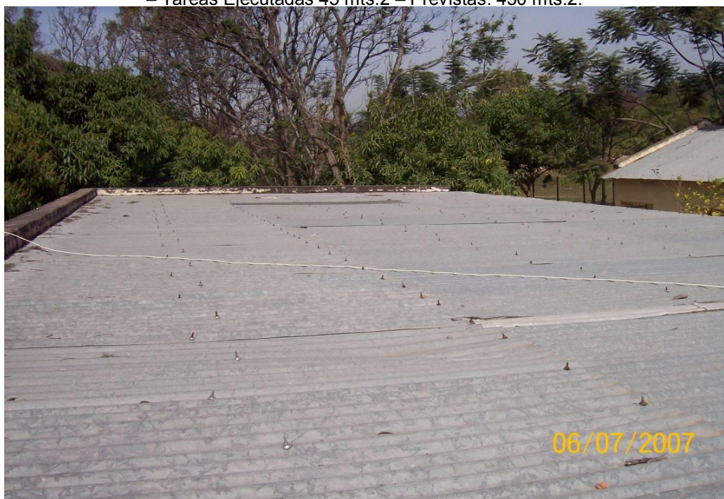
Foto N° 6 Ítem 3.01 “Aislación térmica con membrana de aluminio 4mm en cubierta” – Tareas Ejecutadas 45 mts.2 – Previstas: 450 mts.2
