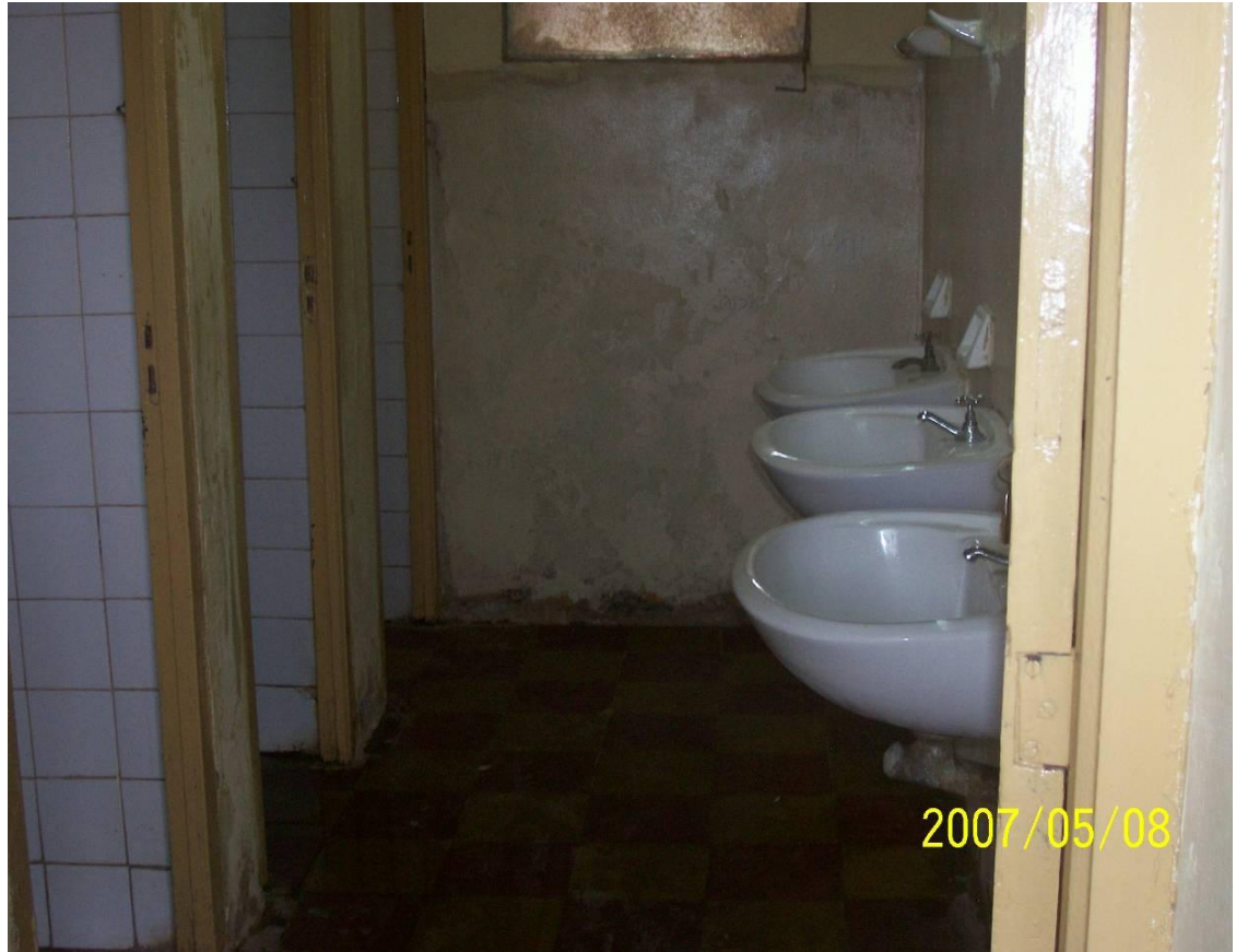
Fotografía N° 1.- Paredes de los núcleos húmedos
