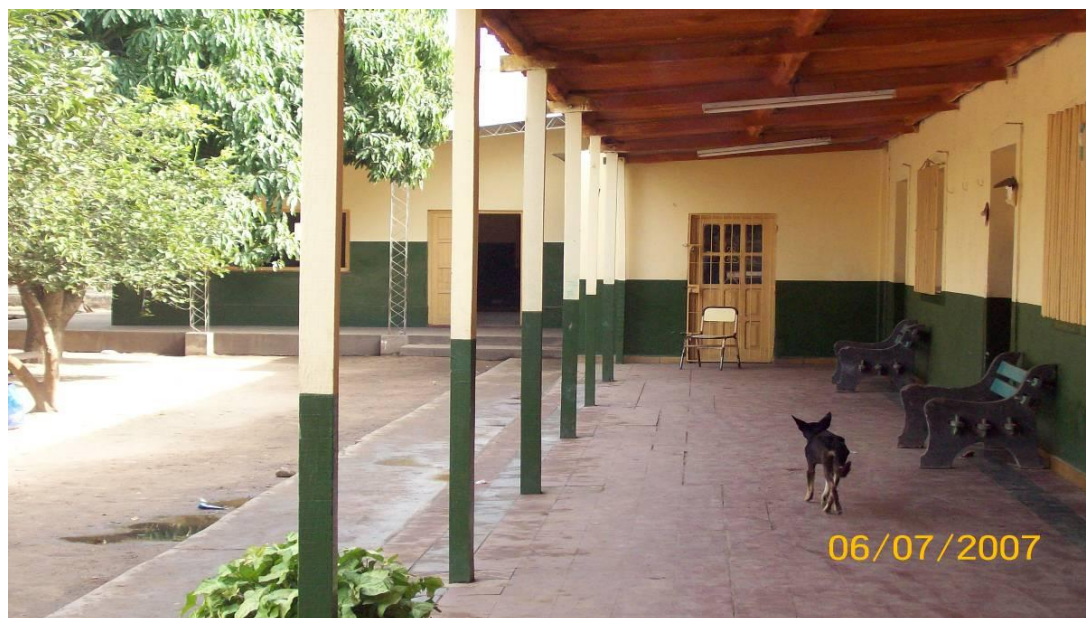
Fotografía N° 8: "Recambio de columnas de madera en galería" Ítem 3.02 del análisis de cómputo y presupuesto.
