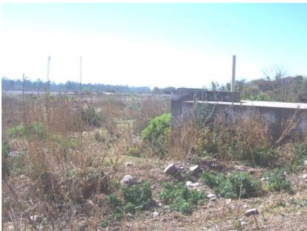
Cámaras de Inspección
