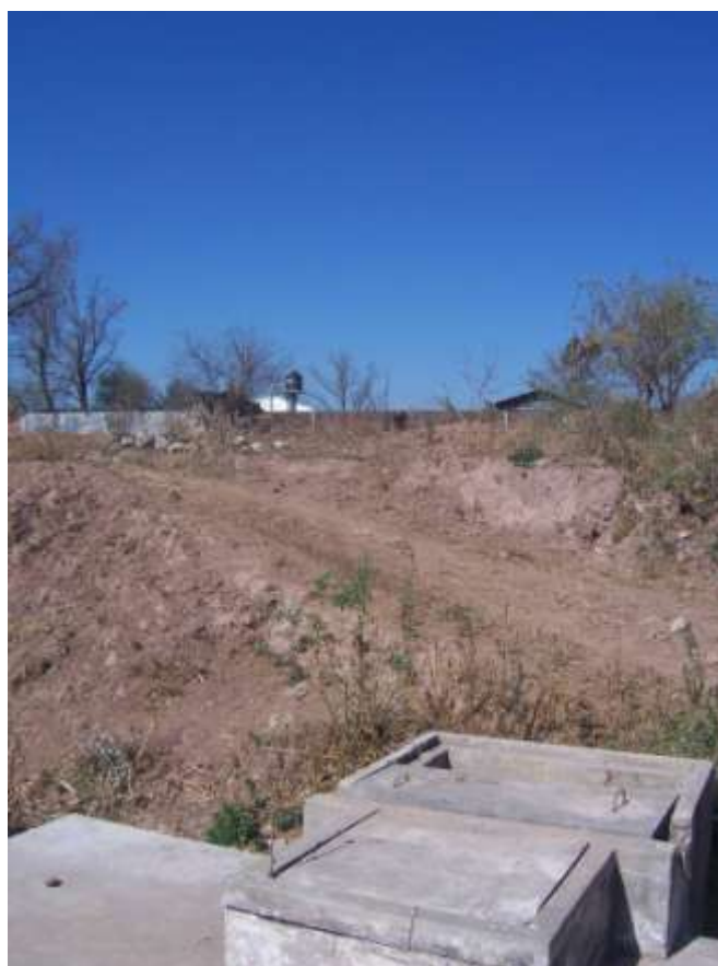
Cámaras de Inspección
