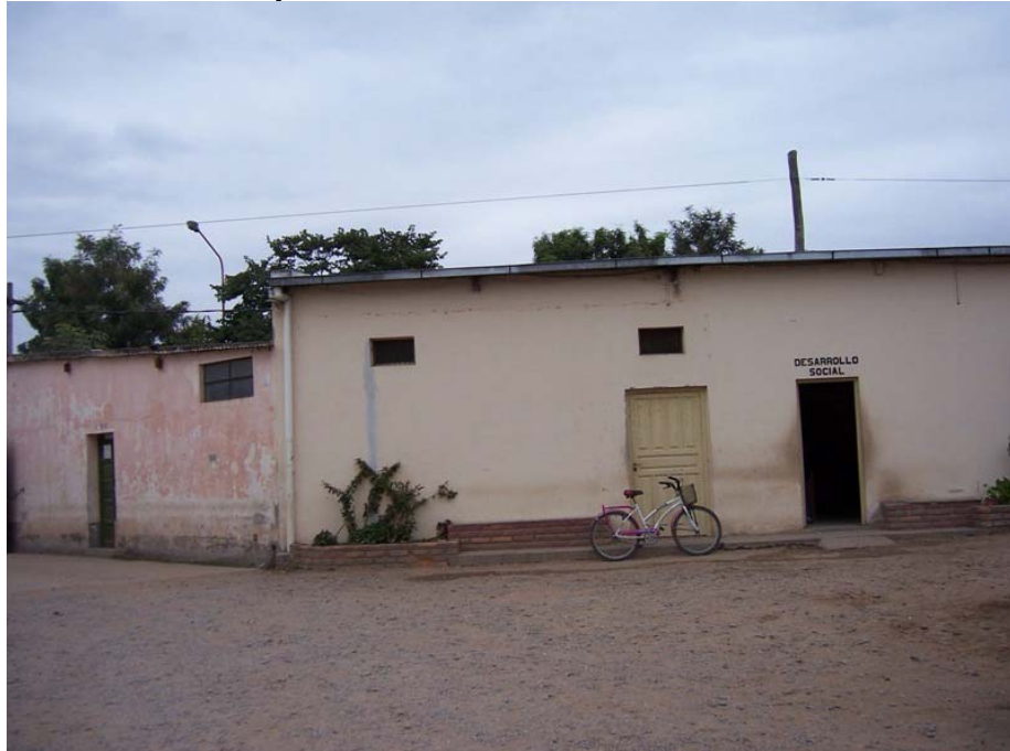
Depósito de Módulos Alimentarios
