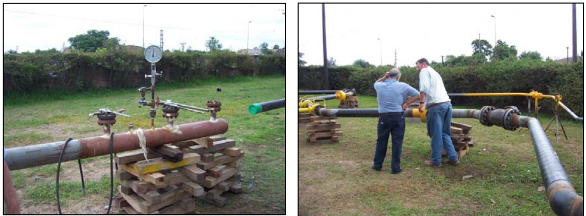
Ensamble y prueba de resistencia de cañerías en el obrador de la empresa contratista ubicado en la ciudad de Metán
