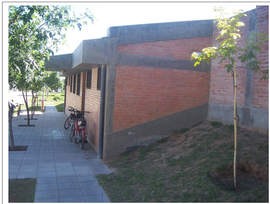
Acceso principal y seguridad
