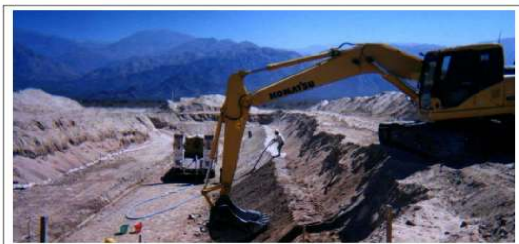
Obras de construcción de Trinchera para Relleno Sanitario en Cafayate
