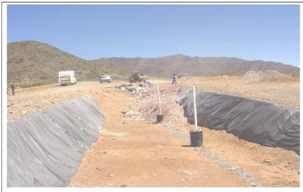
Obra de Ingeniería Sanitaria para la Disposición Final de los Residuos Sólidos Urbanos, para la localidad de Cachi. Departamento Cachi
