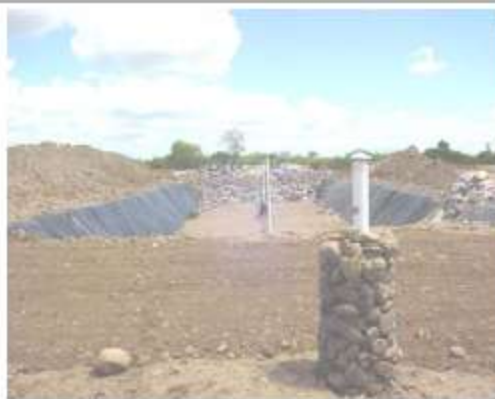
Trinchera en operación
