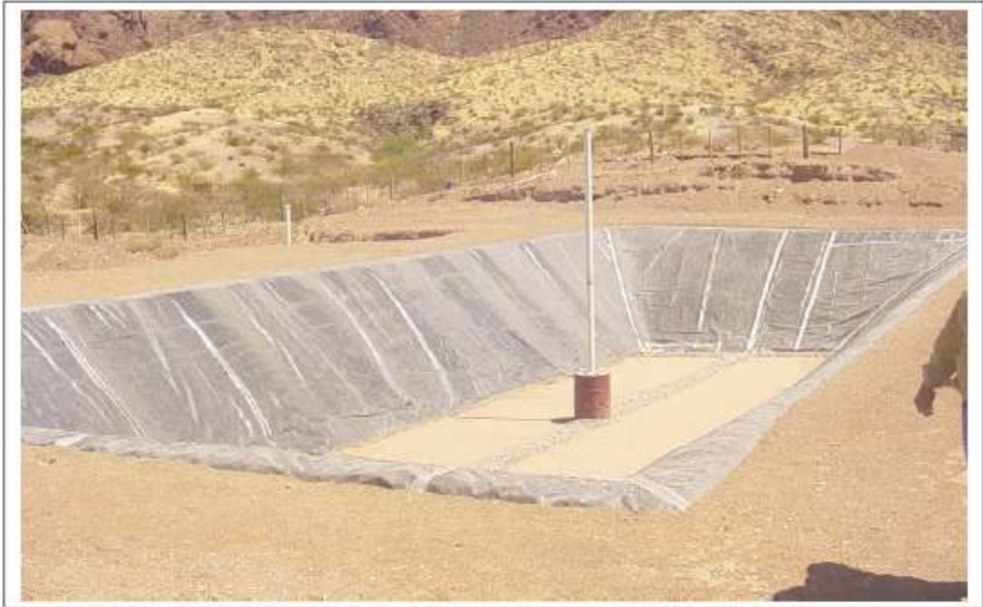
Obra de Ingeniería Sanitaria para la Disposición Final de los Residuos Sólidos Urbanos, para la localidad de Molinos.
