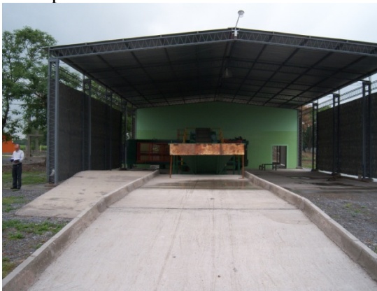
Rampa acceso Vehicular a Tolva
