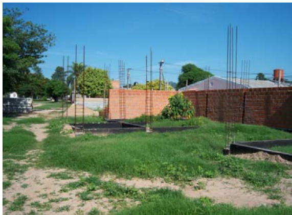
Vista interna desde Avda. H. Lerma a ingreso y Pje. medianero
