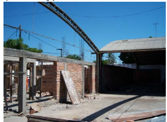
Vista desde Foyer a Galería, L Com. 0,30
