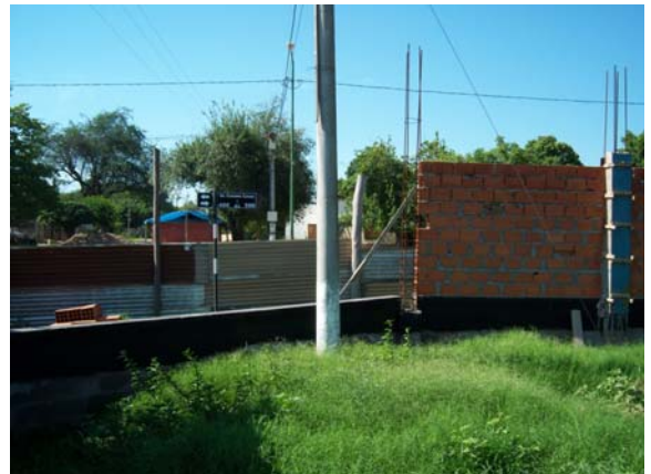
Vista interna hacia ochava
