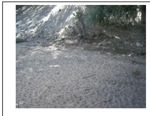
Terraplén Rio Chuscha margen norte
