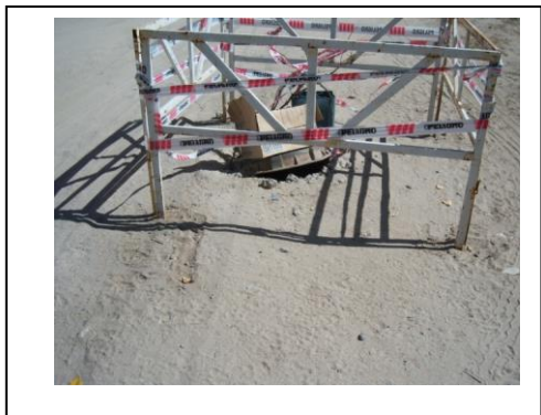
Boca de registro
