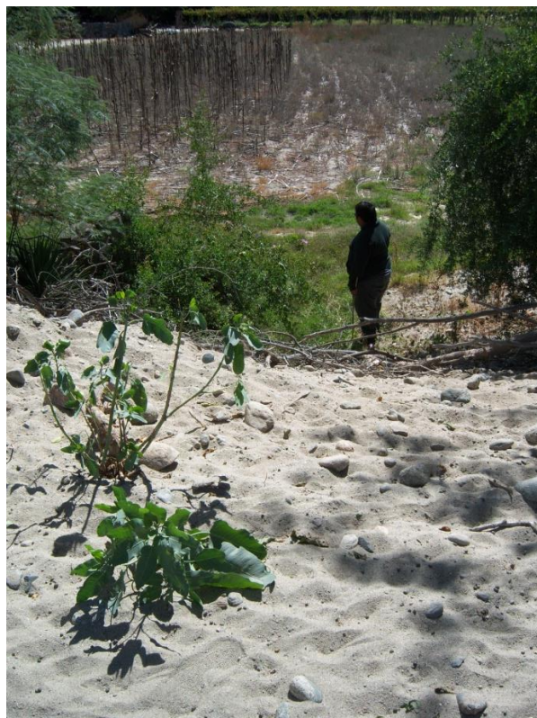
Red conexión a planta tratamiento
