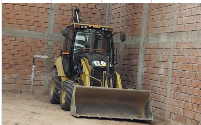
Retroexcavadora CAT Sin Dominio
