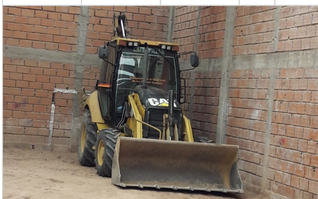
Retroexcavadora CAT Sin Dominio
